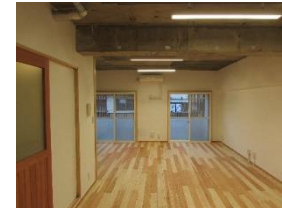
高置水槽撤去
